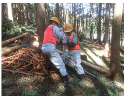
チルホールによるヒノキ材の引き上げ
