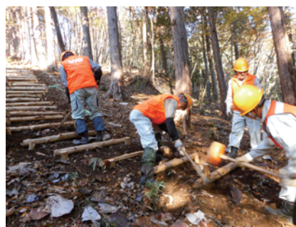
全ての作業は心合わせて
